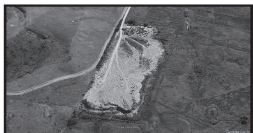
Figura 42 - Antigo "vazadouro" / "lixão" localizado na Rodovia RJ 230, localidade de Usina Santa Isabel Fonte: Secretaria Municipal de Meio Ambiente, Agricultura e Recursos Hídricos (2024)
